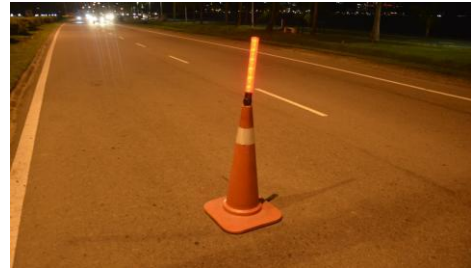
Gambar 38 : Meletakkan lampu hazard pada waktu malam di kawasan penyelenggaraan. Sumber : JPBW
