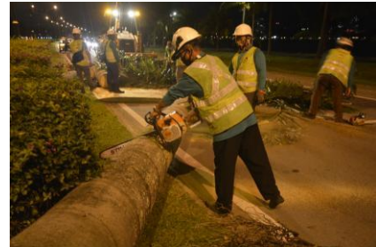
Gambar 53 : Pengendalian mesin chainsaw semasa pemotongan pokok. Sumber: JPBW
