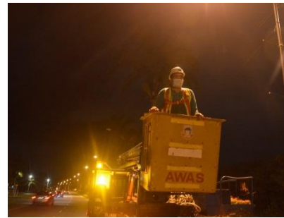
Gambar 48 : Kekal berada di platform kerja semasa skylift bergerak.
